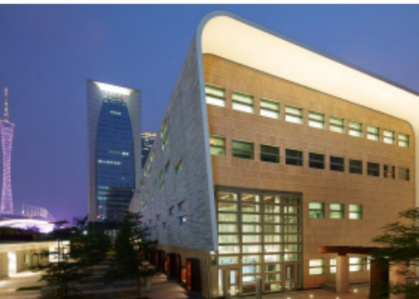
史立宾（职大建83-6班） 主持施工的广州美国领事馆工程
