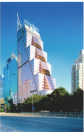
陈勇（建81-11班） 主持施工的深圳发展银行工程
